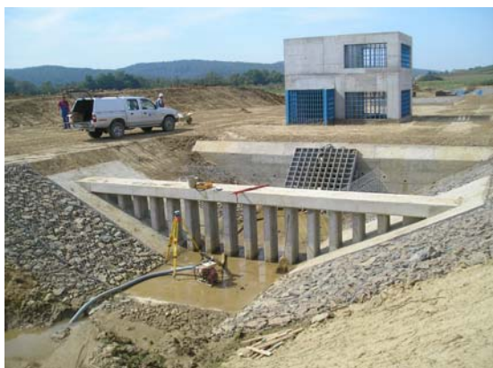
Retencija - akumulacija „LONDŽA“ – u izgradnji (gruba rešetka, ulazni prag i uljevno okno)
