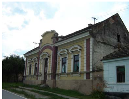
Zgrada stare općine u Ruševu
